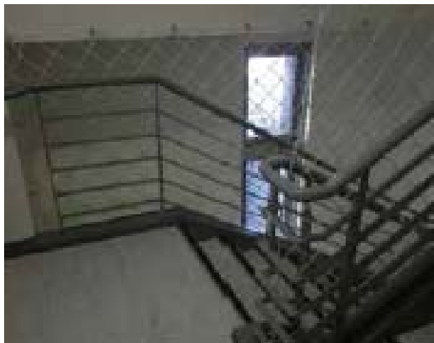
樓梯加裝防墜網
