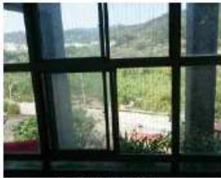
圖 3 加裝防護格柵
