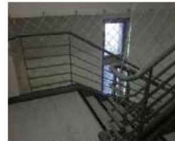
圖 5 樓梯加裝防護網
